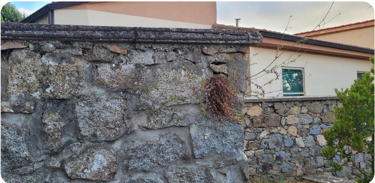
Degrado del cemento armato con perdita del copriferro nelle copertine dei muri di contenimento.
