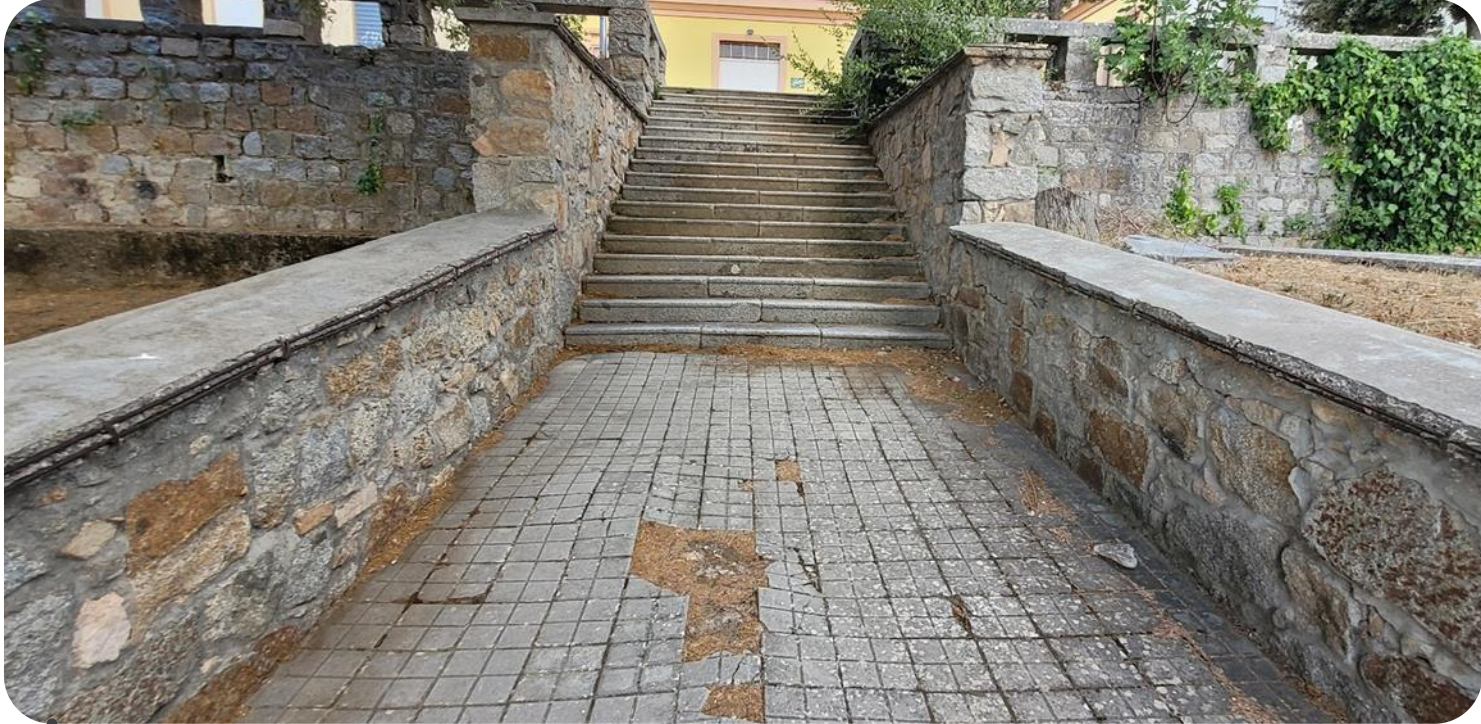
Dissesto della pavimentazione dei pianerottoli nella scalinata.
