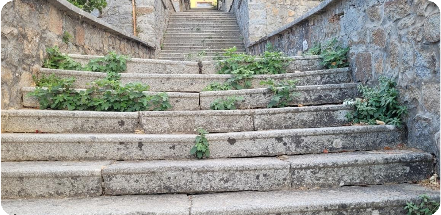
Cedimento del piano di posa sottostante.
