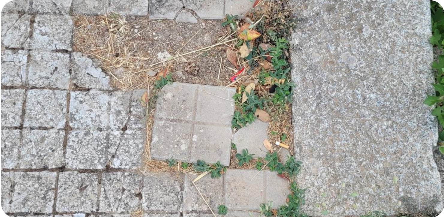
Distacco e disomogeneità della pavimentazione.
