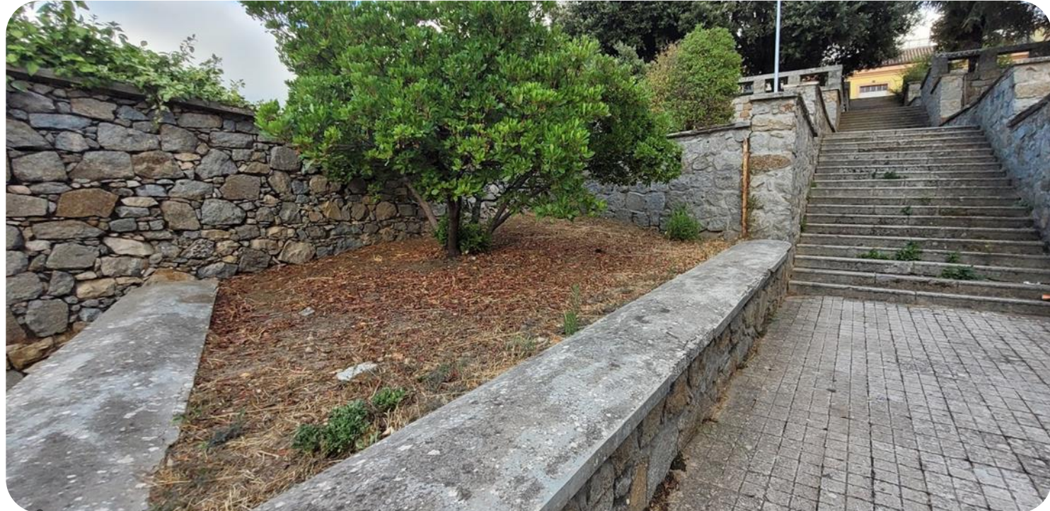
Perdita della malta di finitura sui muretti a confine dei terrazzamenti.
