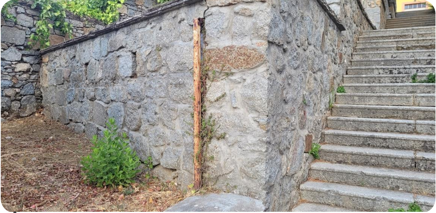
Degrado delle canalette metalliche esterne dell'impianto di illuminazione.
